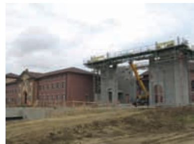
Bilder während des Bauzeit
