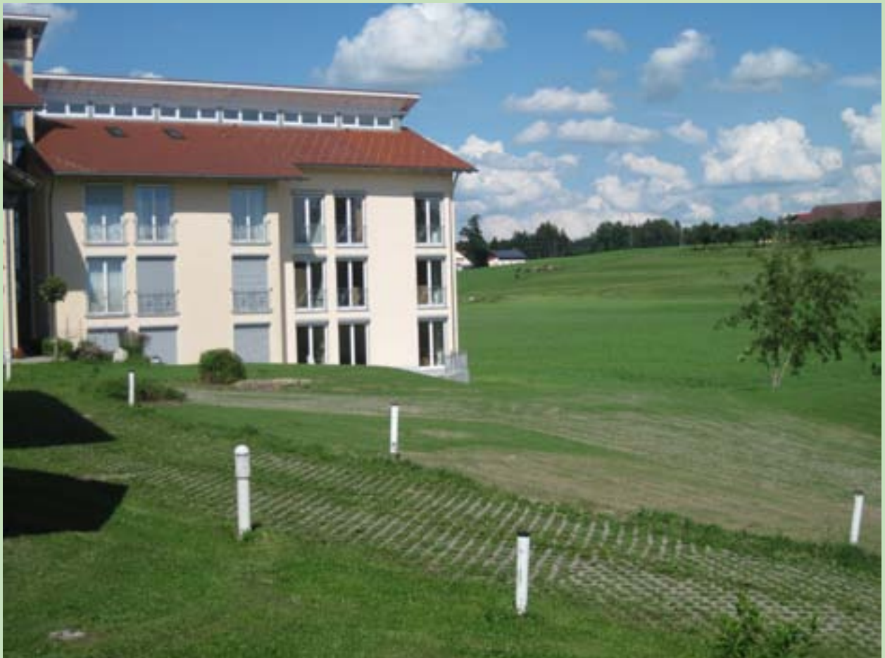
Auf der ehemaligen Baustellenzufahrt wächst schon der Rasen
